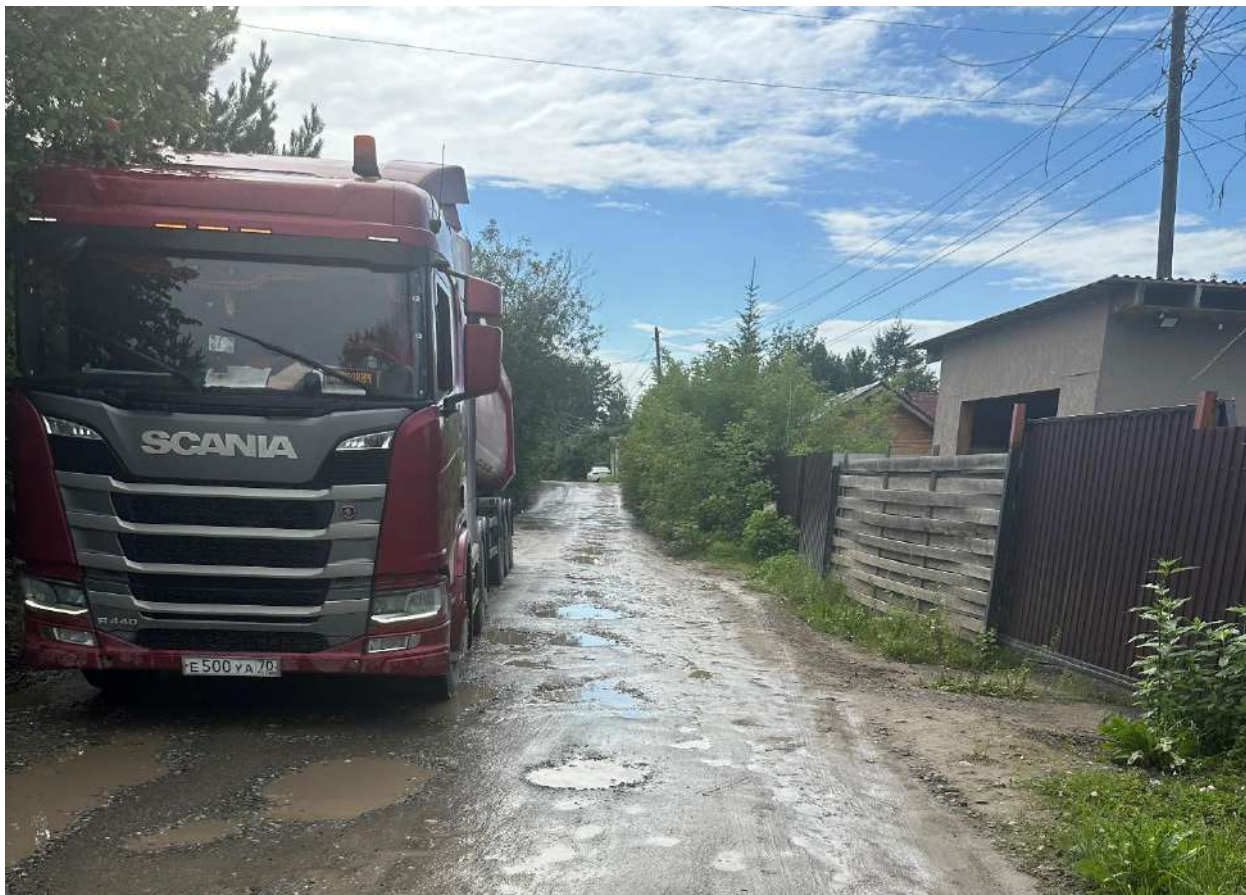
Доставка щебня фр.20-40, 2 машина, 35 т. (Центральная дорога)
