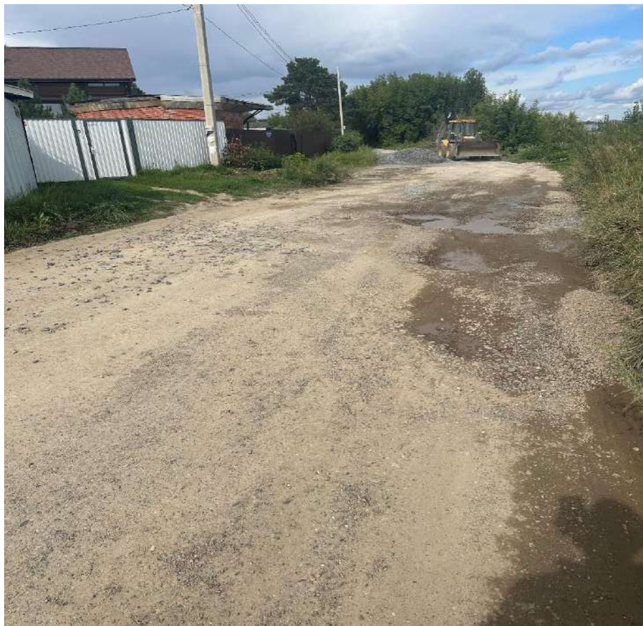
Участок №5307 в направлении уч.№5310 отсыпка щебнем фр.20-40
