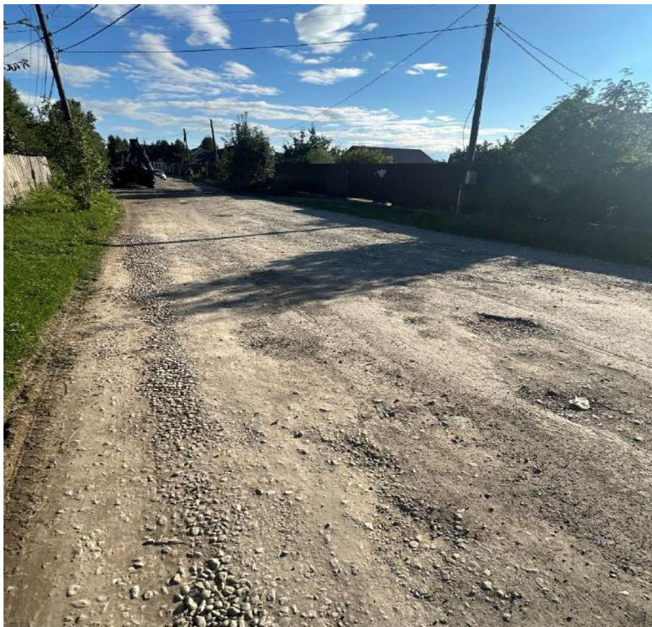
Участок №7205 в направлении уч.№7203 отсыпка щебнем фр.20-40
