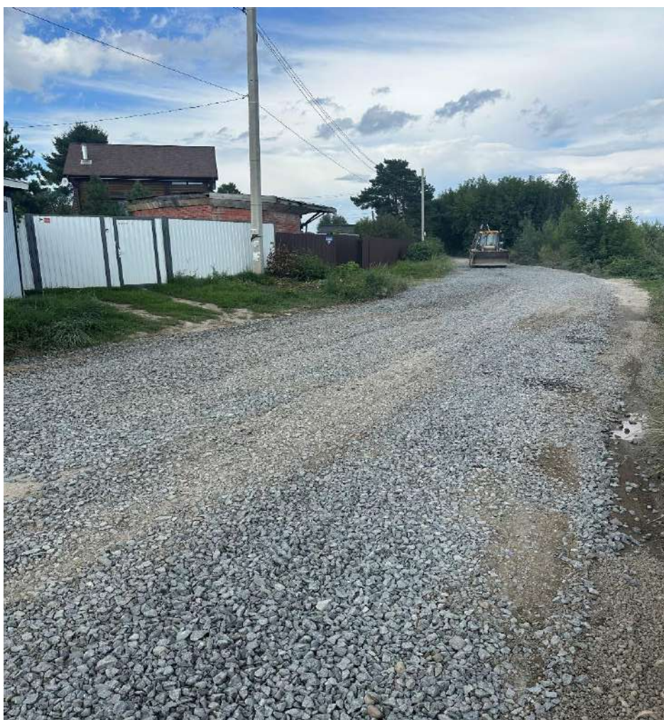
Участок №5307 в направлении уч.№5310 отсыпка щебнем фр.20-40
