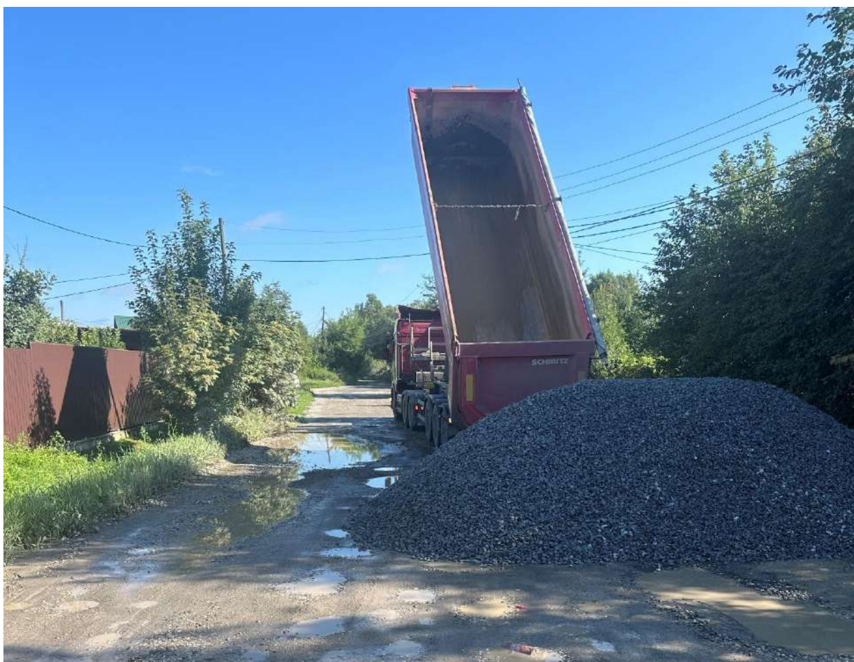
Доставка щебня фр.20-40, 1 машина, 35 т. (Центральная дорога)
