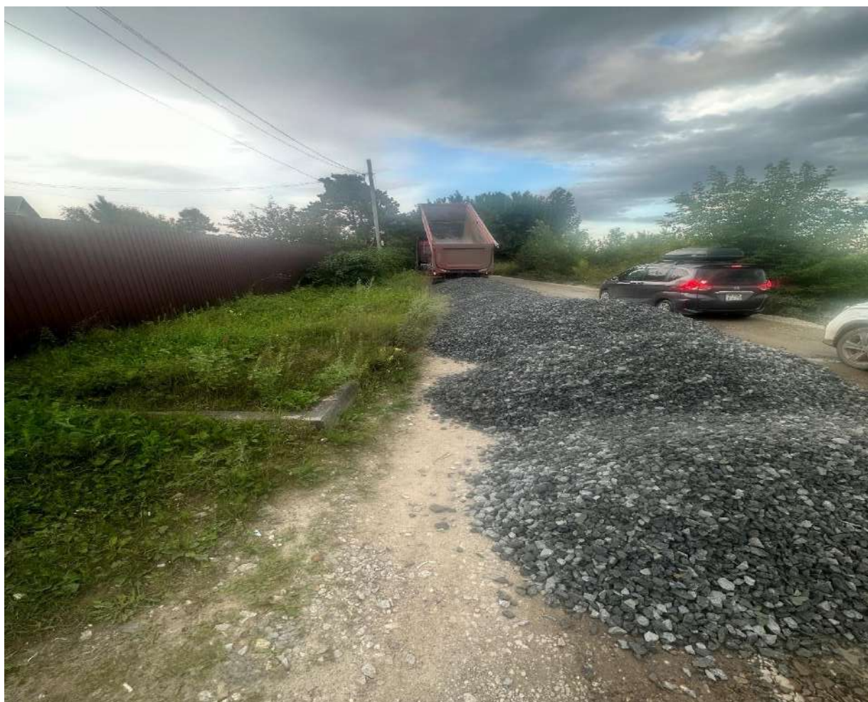
Доставка щебня фр.20-40, 3 машина, 35 т. (Центральная дорога)
