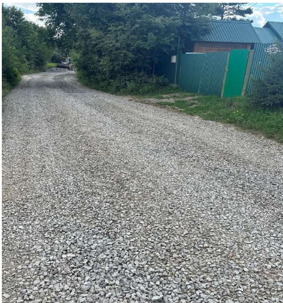
Участок №5605 в направлении уч.№5802 отсыпка щебнем фр.20-40
