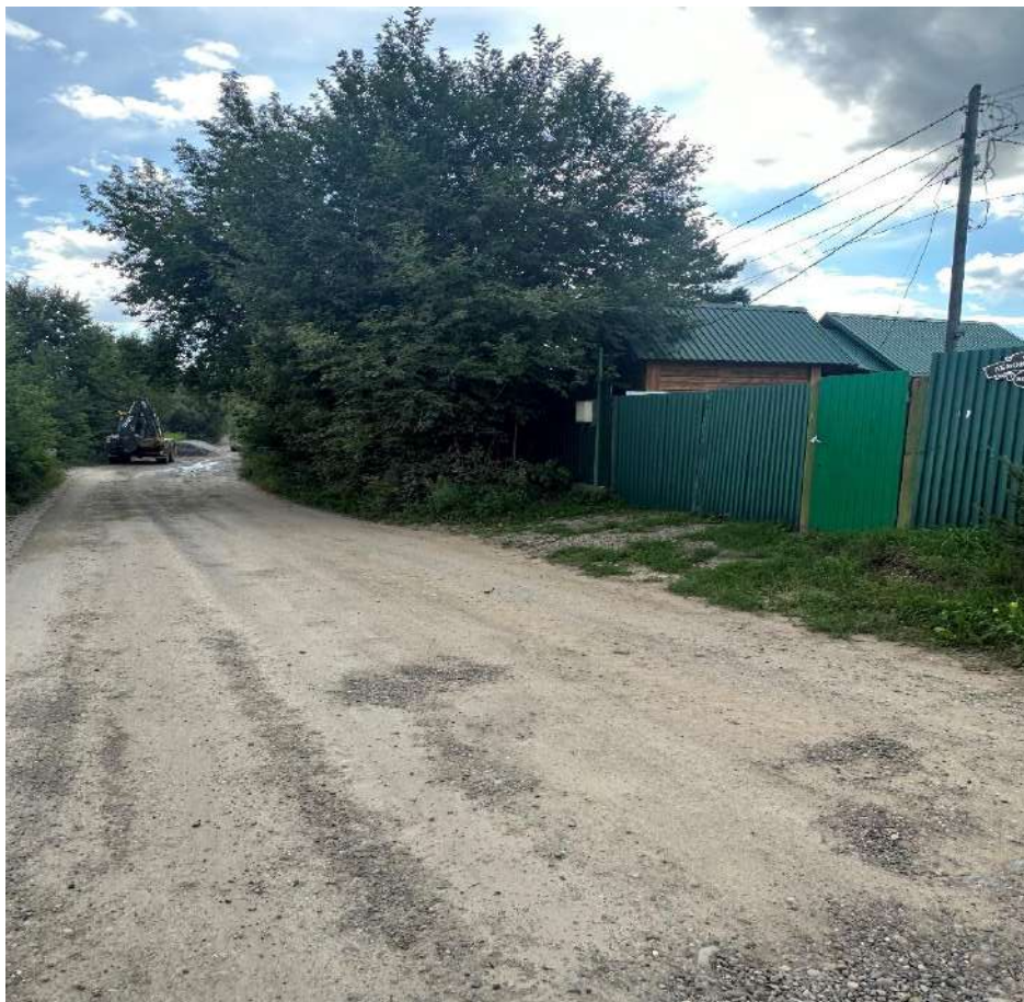
Участок №5605 в направлении уч.№5802 отсыпка щебнем фр.20-40
