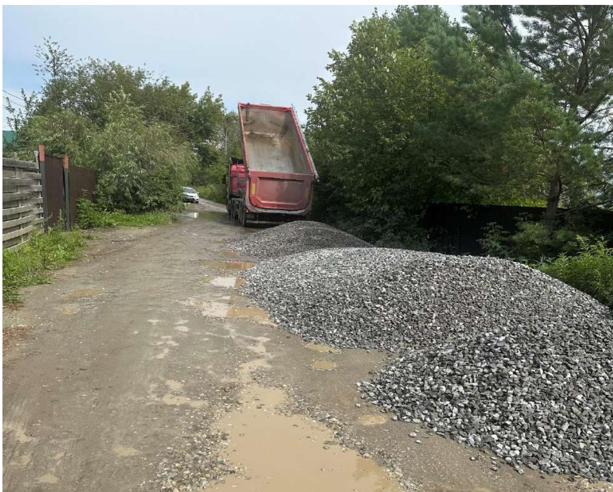
Доставка щебня фр.20-40, 2 машина, 35 т. (Центральная дорога)
