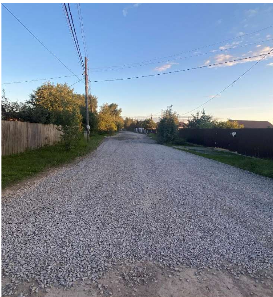
Участок №7205 в направлении уч.№7203 отсыпка щебнем фр.20-40
